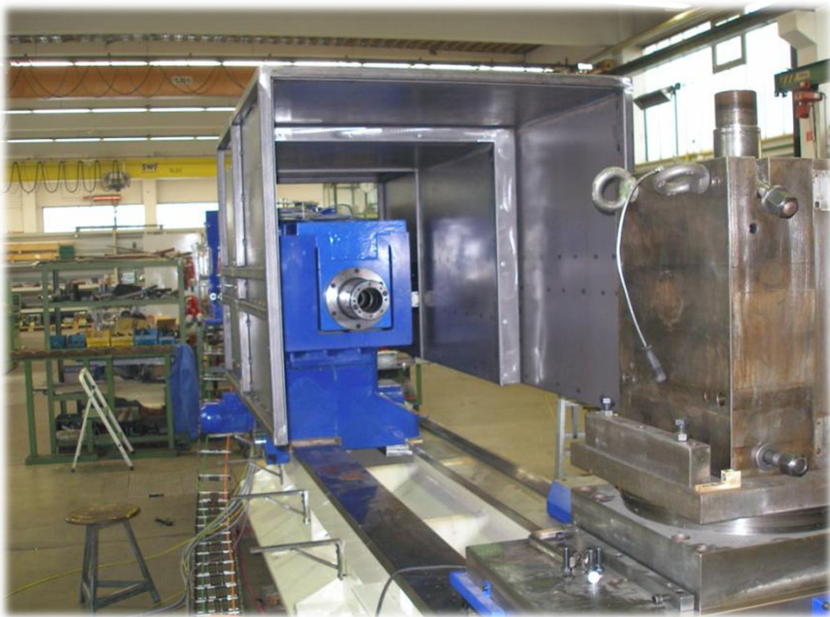
Schiebeschutz auf der Maschine montiert für Elektroarbeiten
